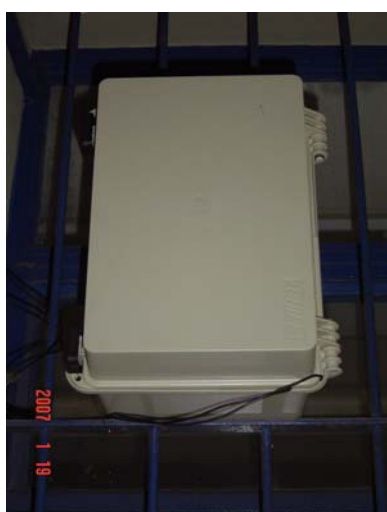
Figura 9. Detalhe da instalação de uma URME
